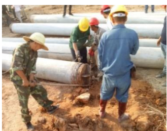
注浆桩尖焊接
