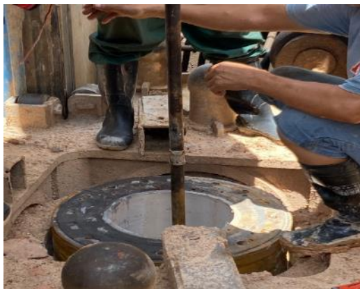
④ 注浆管连接
