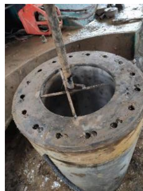
④ 注浆管固定
