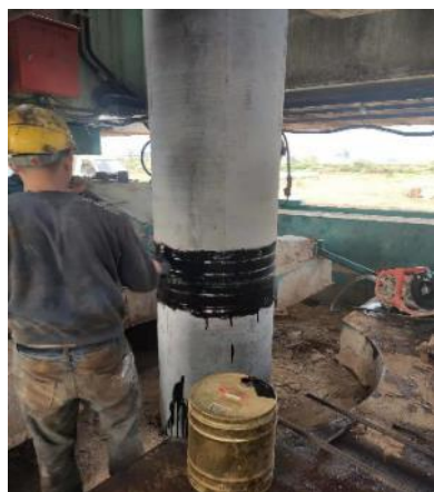
⑥ 涂抹防腐涂料
