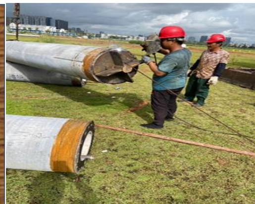
③ 桩尖焊接
