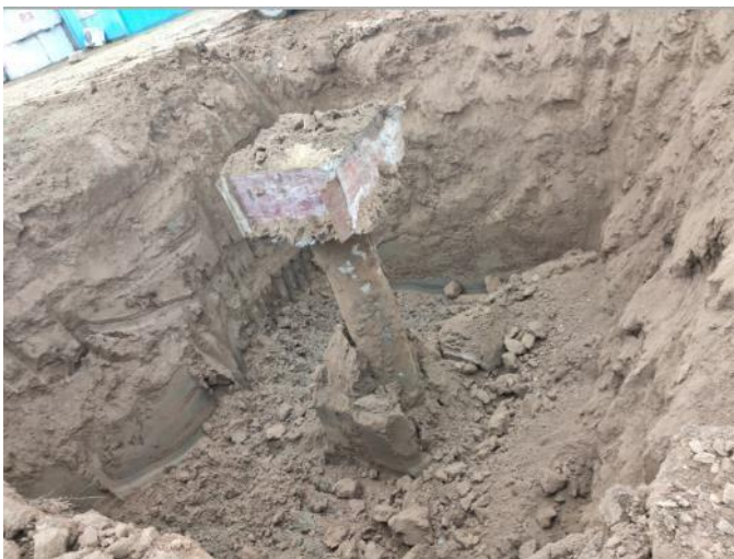
2#开挖5m未发现水泥浆
