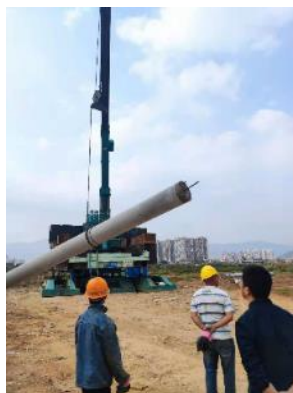
③ 管桩起吊
