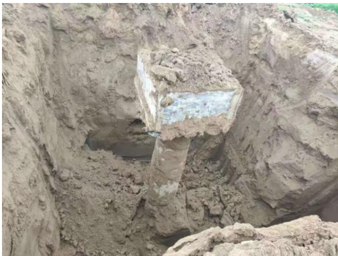
1#开挖5m未发现水泥浆
