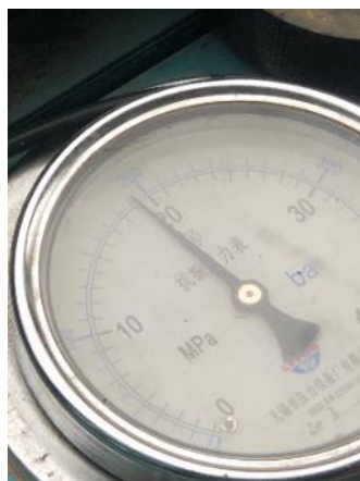
⑦ 控制收桩压力
