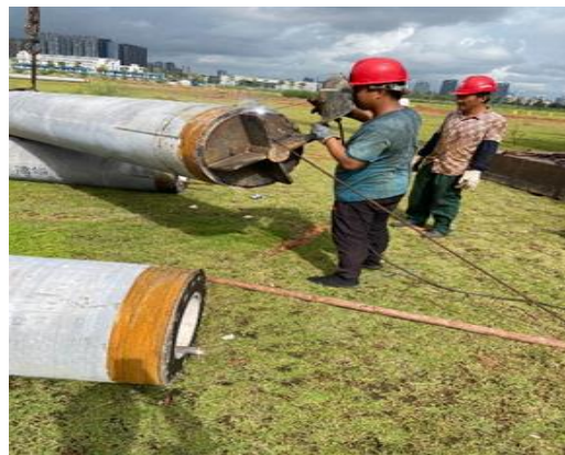
② 桩尖焊接
