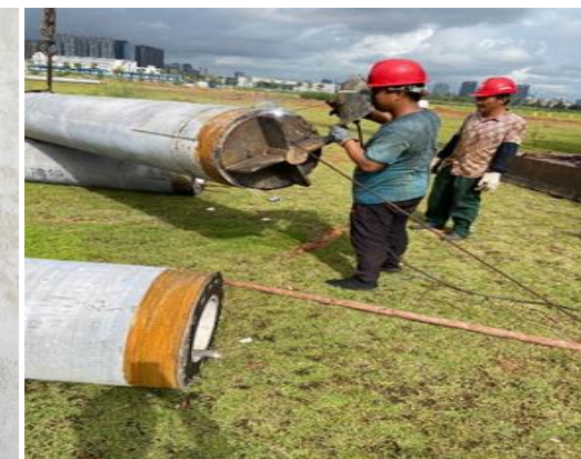
③ 桩尖焊接
