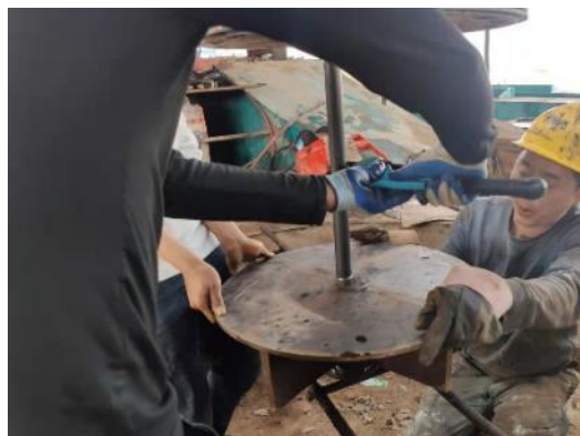
① 桩尖焊接
