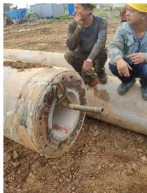
② 注浆管安装
