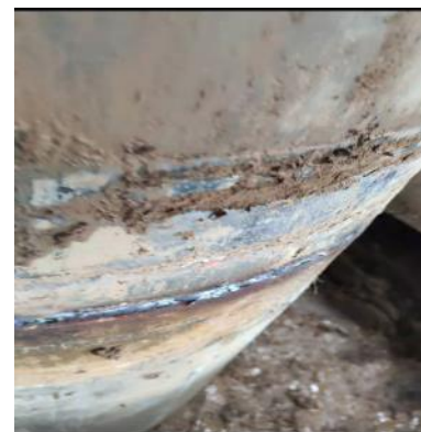
⑤ 管桩焊接
