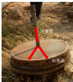
注浆桩尖加工
